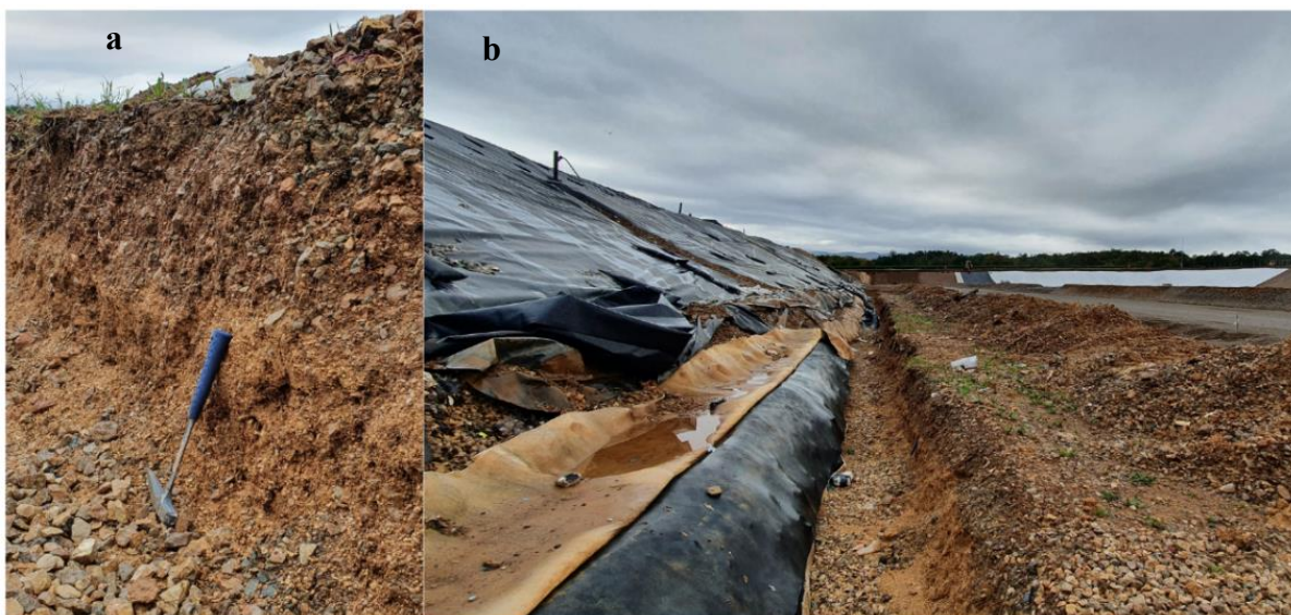
Slika 12. Sidreni jarak plohe 1B (a: mjesto uzimanja uzoraka temeljnog tla fotografirano izbliza, b: sidreni jarak u kojem su uzorci fotografiran s udaljenosti) (foto: Ivan Deotto)
