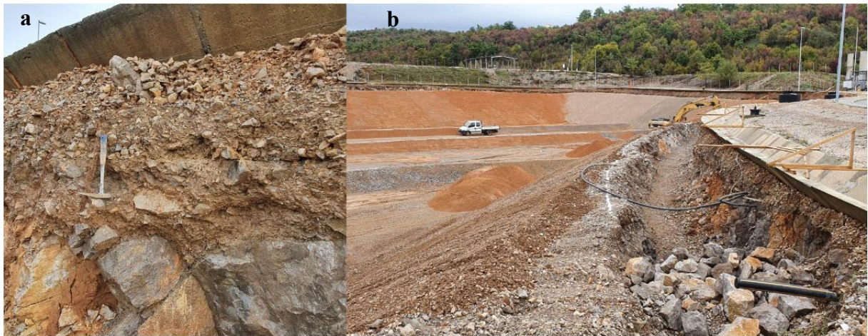
Slika 13. Sidreni jarak iza bočne plohe 1B ( a : izbliza fotografiran sidreni jarak bočne plohe, b : sidreni jarak bočne plohe fotografiran s udaljenosti) gdje su uzeti uzorci temeljnog tla (foto: Ivan Deotto)
