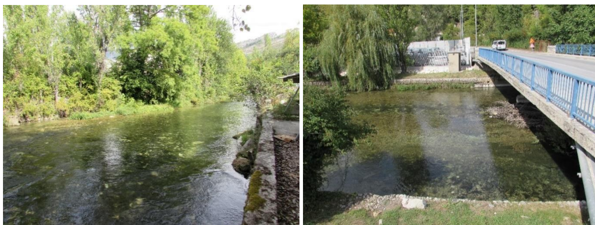
Sl. 22. i 23. Primjeri regulacija obale: betonirana lijeva obala i kameni nabačaj na desnoj obali rijeke nizvodno od hidrološke stanice Jadro-Majdan ( lijevo ) te pogled nizvodno sa sličnim obrascem ( desno ).
