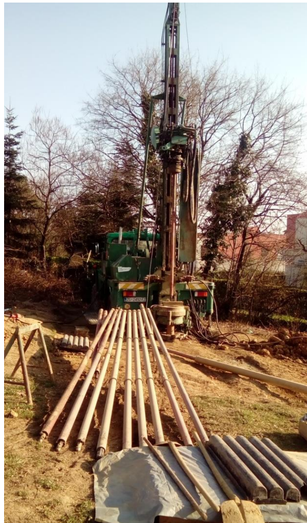
Slika 3. Garnitura za bušenje na lokaciji BGG zgrade na Horvatovcu.
