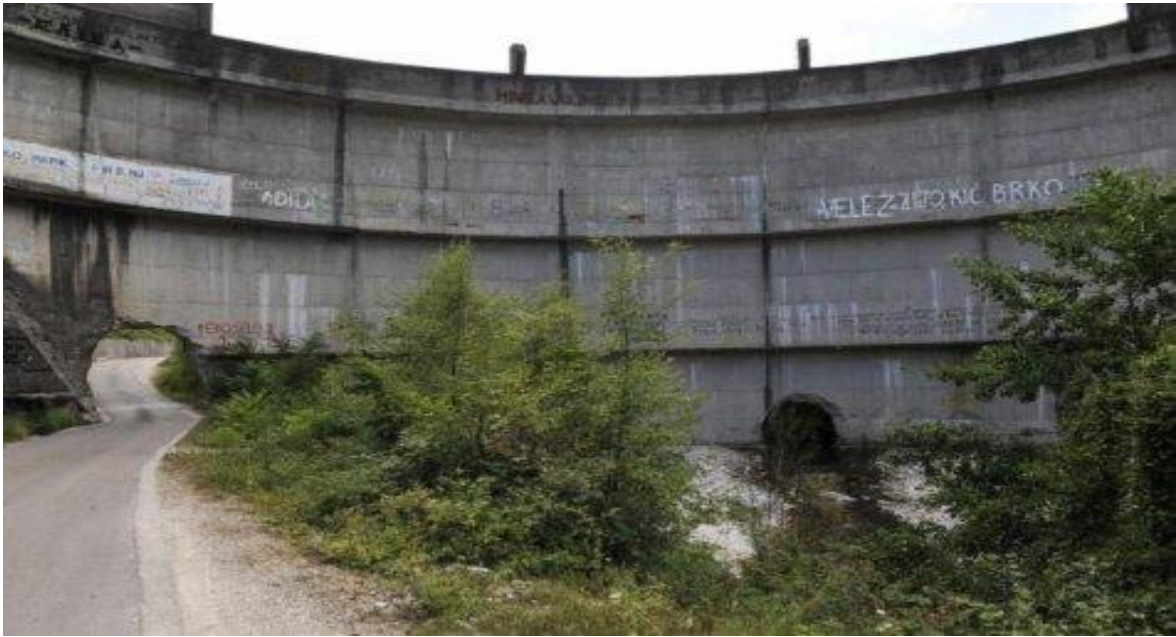
Sl. 25. Brana Idbar na rijeci Baščici kod Konjica izgrađena 1959. godine
