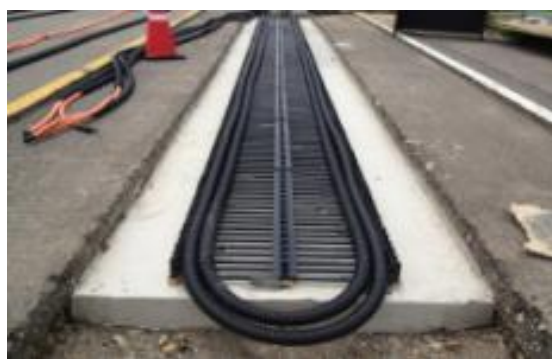
Slika 11. Izgled ceste koja omogućuje vožnju principom indukcije
