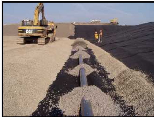
Slika 3. Prikaz izgradnje drenažnog sloja sa perforiranom cijevi
