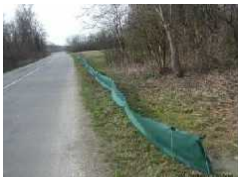
Slika 9.) Izgled mreže postavljene uz cestu
