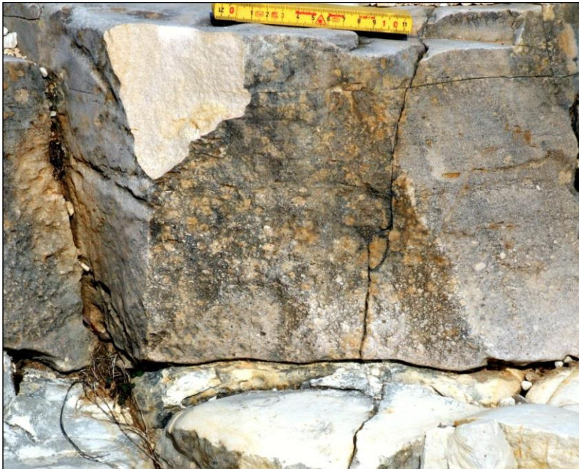
Sl. 13 Klasični (Bouma) turbidit debljine oko 45 cm (Ta-c) s erozijskom bazom i jasnom normalnom gradacijom od 1–2 cm velikih "rip" klasta i srednjozrnastog pijeska u bazi do vrlo sitnog pijeska na vrhu. Gornja slojna površina je nepravilno, blago valovita te se vjerojatno radi o tankim, izoliranim strujnim riplovima. Mjerilo je dugo 22 cm.
