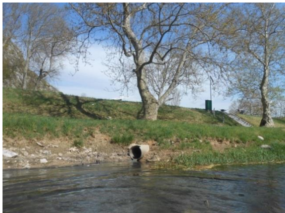
Slika 6 Ispust komunalnih otpadnih voda grada Knina u rijeku Krku (foto: Vlatka Filipović Marijić)
