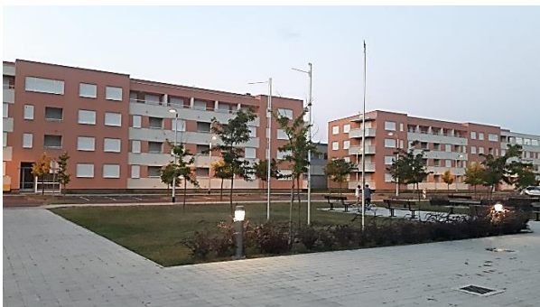
Sl. 12. Dvije neuseljene stambene zgrade
