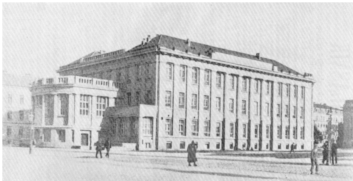
Slika 60b. Fotografija zgrade Kraljevskog sveučilišnog kemijskog zavoda u Zagrebu 1920. godine (Kaštelan-Macan, 1989.)
