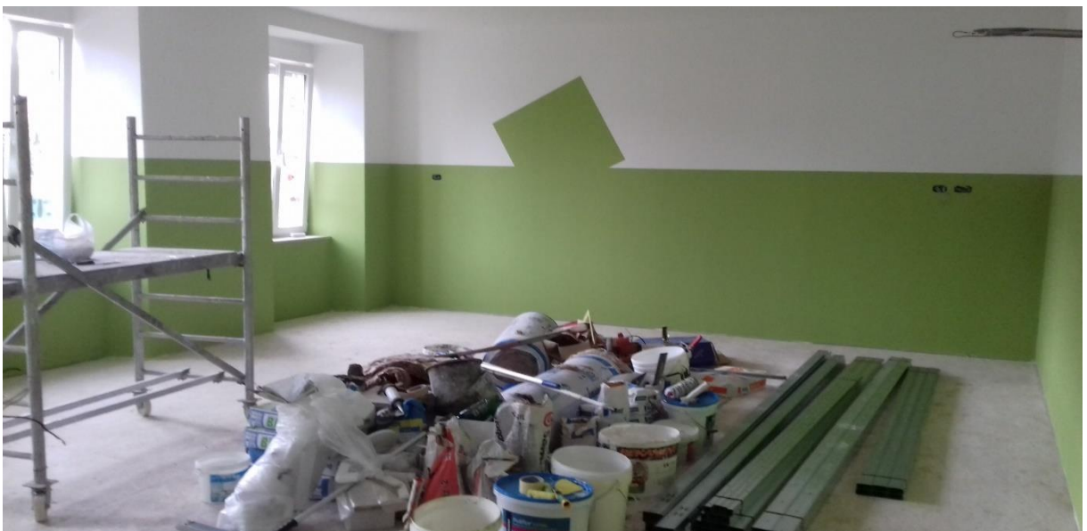
Sl. 18. Radovi na preuređenju zgrade nekadašnje područne škole u Velome Maju Izvor: Snimio autor (8. 11. 2018.)
