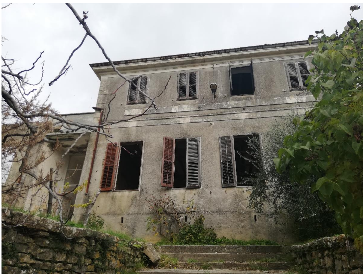
Sl. 12. Napuštena zgrada nekadašnje područne škole u Krasici
