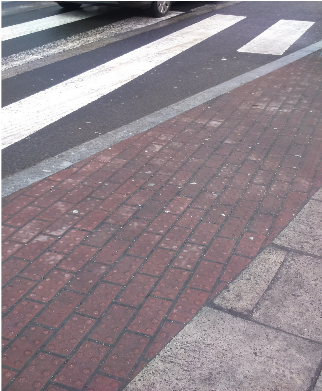
Sl. 21. Taktilna staza na pješačkom prijelazu u Krakovu
