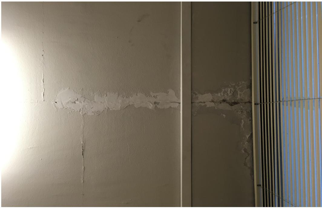
Slika 4.3: Pukotine u prizemlju zgrade Geofizičkog odsjeka, površinski zatvorene uslijed reparacije.
