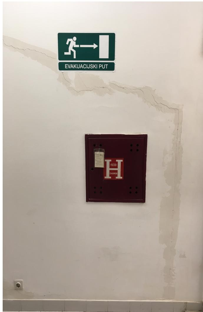
Slika 4.4: Pukotine u podrumu zgrade Geofizičkog odsjeka, ispred prostorije 115, površinski zatvorene uslijed reparacije.
