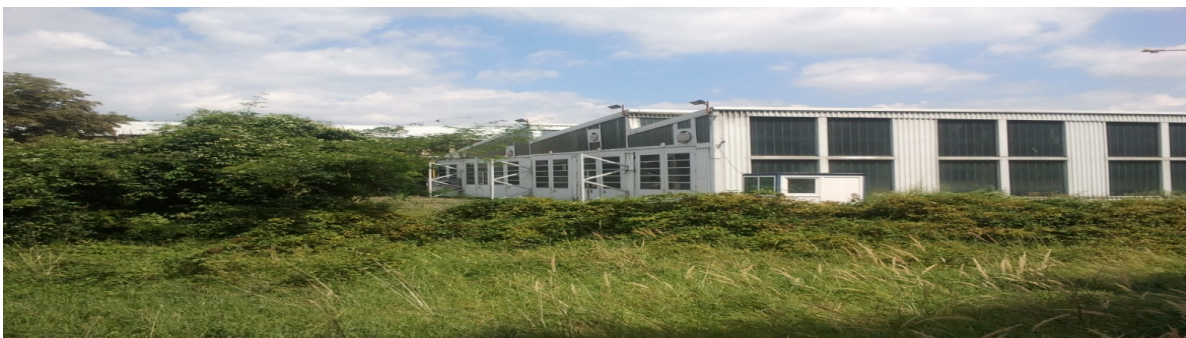
Sl.16. Proizvodne hale TŽV Gredelj na lokaciji Trnjanska – Strojarska (12. srpnja 2014.)
