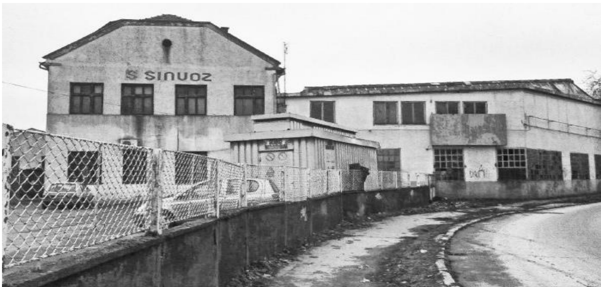
Sl.8: Napušteni hangari i postrojenja tvornice „Šinovož“
