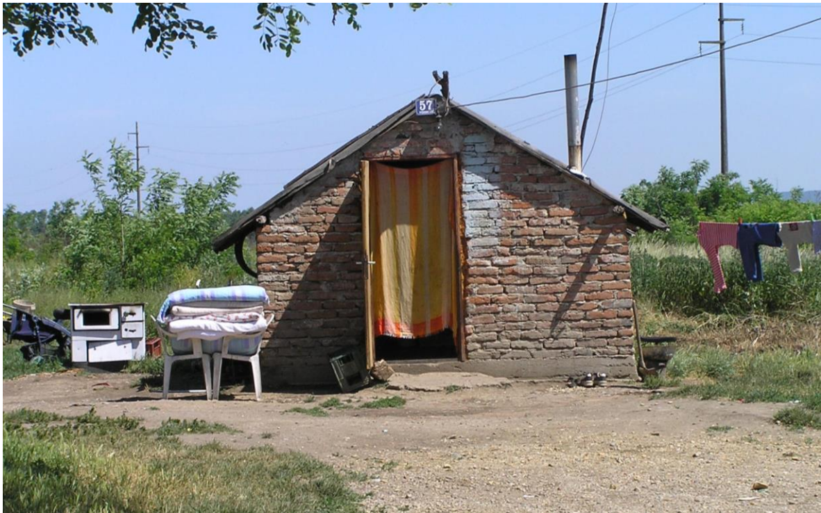
Sl. 54. Površinom mali stambeni objekt u romskom naselju Piškorovec Foto: H. Šlezak, 2010.
