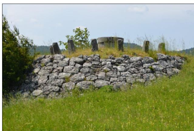
Slika 177. Kamena cisterna na lokalitetu Razvala na južnoj padini Kapele okružena kolobranskim stupovima i kamenim podzidom (P. Feletar, 2014.).
