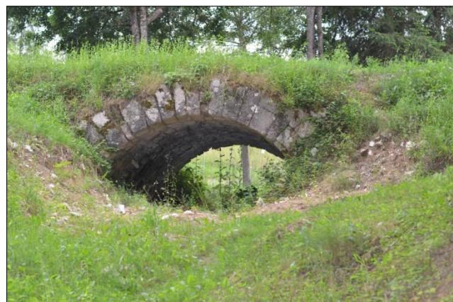
Slika 167. Kameni mostić na staroj trasi Jozefinske ceste u Potoku Tounjskom – takvih jednolučnih boltanih mostova na trasi Jozefine izgrađeno je desetak (P. Feletar, 2014.)
