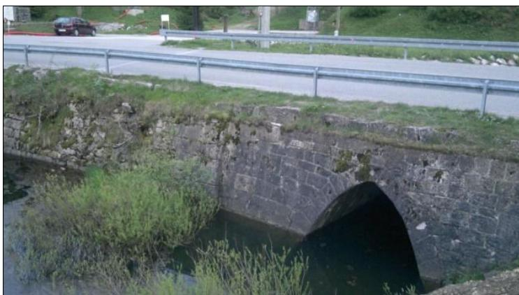
Slika 217. Kameni svoden most na staroj trasi Lujzinske ceste kod Mrzle Vodice (P. Feletar, 2014.)
