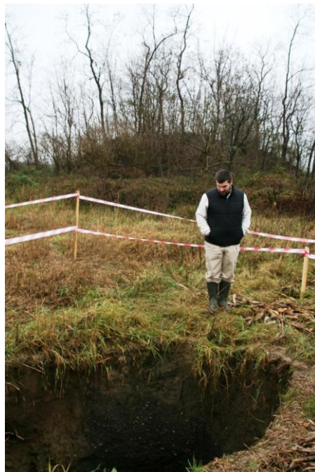
Sl. 43 Urušavanje terena uz haldu 19 koje se desilo u studenom 2014. godine (03. 12. 2014.)
