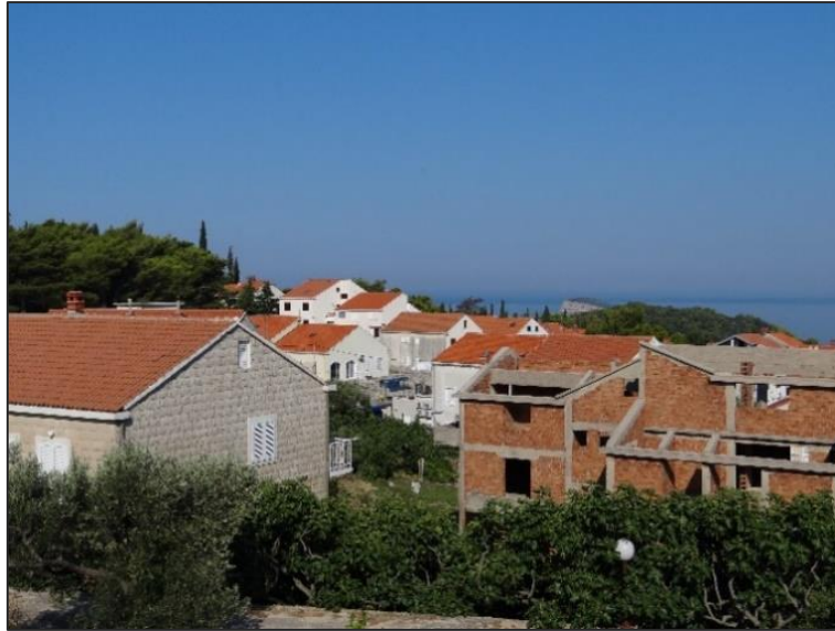
Sl. 133. Izgradnja smještajnih kapaciteta u Cavtatu Foto: I. Šulc (2012)
