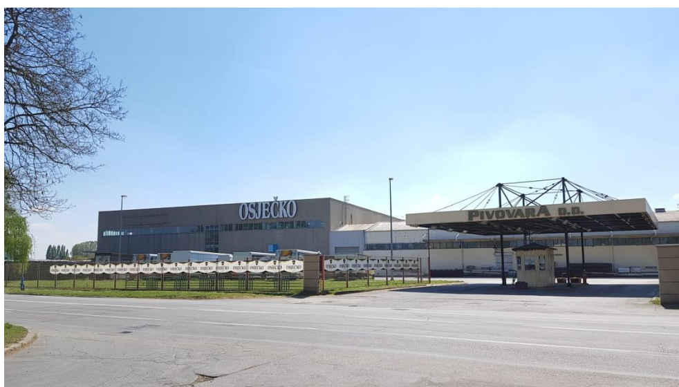
Sl. 32. Zgrada osječke pivovare Snimio: Mislav Zemljak (19. 4. 2019.)
