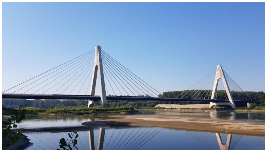
Sl. 2. Novoizgrađeni most koji se nalazi na koridoru Vc preko rijeke Drave, kod naselja Petrijevcu
