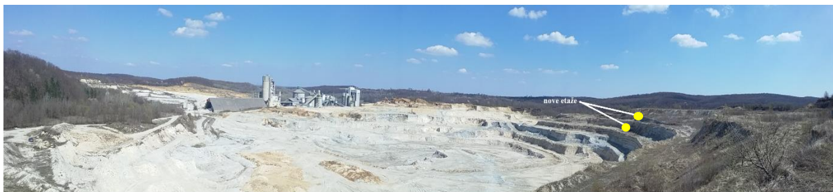
Slika 11. Panoramski pogled na kamenolom Našicecement, d.d. i označen položaj novih etaža.
