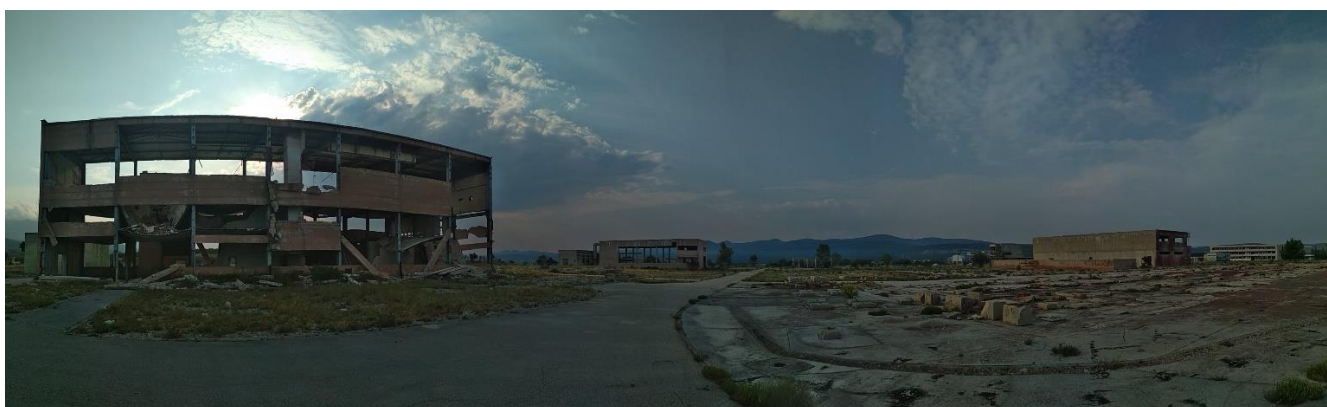
Slika 21. Pustoš i ruševine tvornice Jadral, 24.8.2019.
