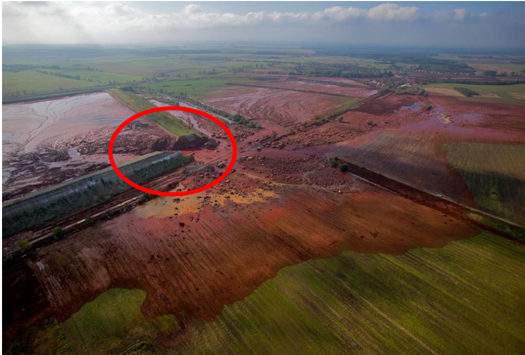
Slika 2. Puknuće zaštitnog zida spremnika 10 (označeno crvenom elipsom). Prilagođeno prema URL4.
