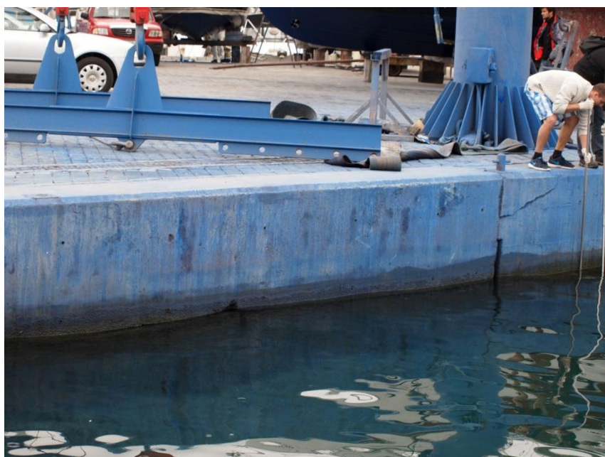
Slika 12. Postaja Zadar-marina; mjesto postavljanja kaveza
