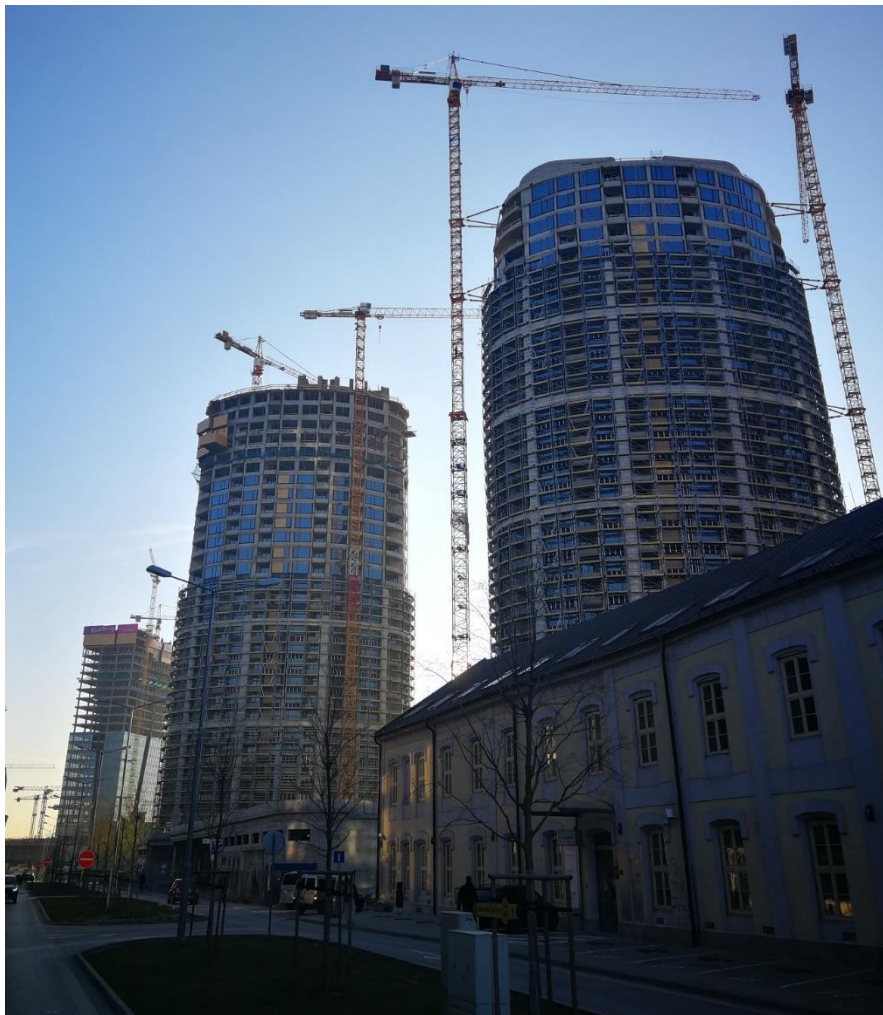
Slika 11. Izgradnja poslovne zone u Bratislavi
