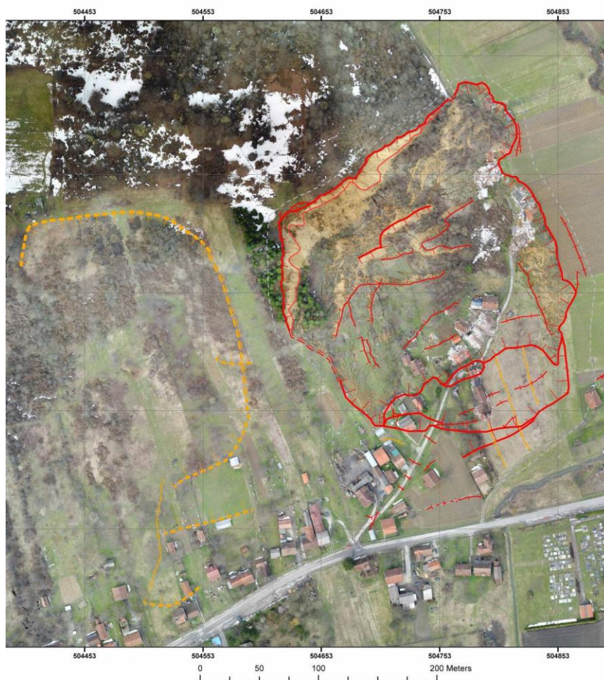
Slika 4.2.1. Klizište Kubarnovo brdo - Stari put (crvena linija-granice klizišta; žuta linija-potencijalno klizište (Podolszki, 2018))
