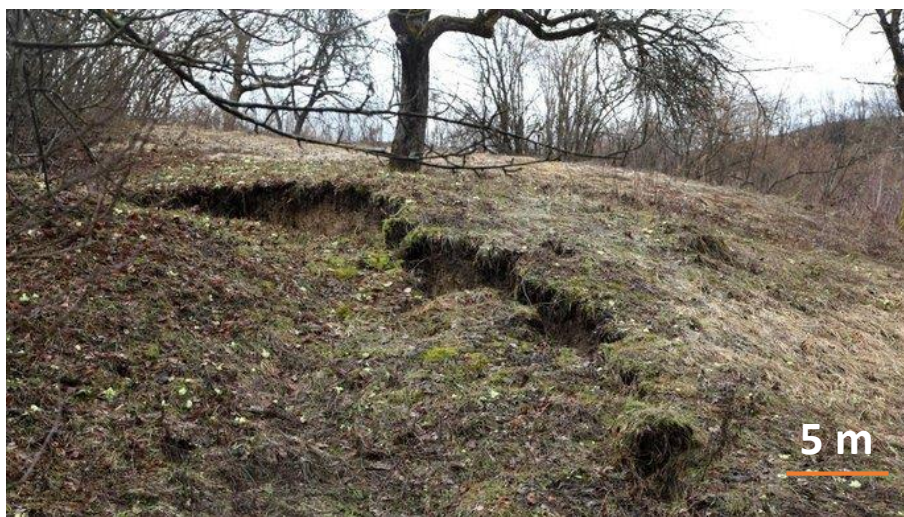
Slika 4.3.3. Pukotina klizišta u Prnjavoru Čuntičkom
