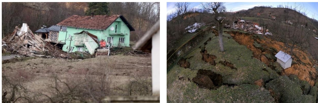
Slika 4.2.6. Posljedice klizišta u Hrvatskoj Kostajnici ( www.pixsell.hr )
