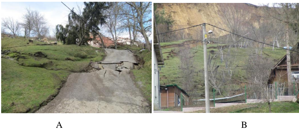
Slika 4.2.5. Znakovi nestabilnosti na području Kubarnovog brda: A) valovita padina B) nakrivljeni stupovi
