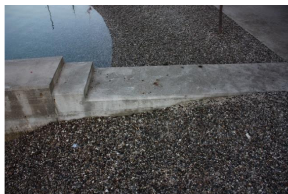
Slika 25. Prekrivenost krupnijim šljunkom do razine betonskog mola DRS (16.6.2019.).
