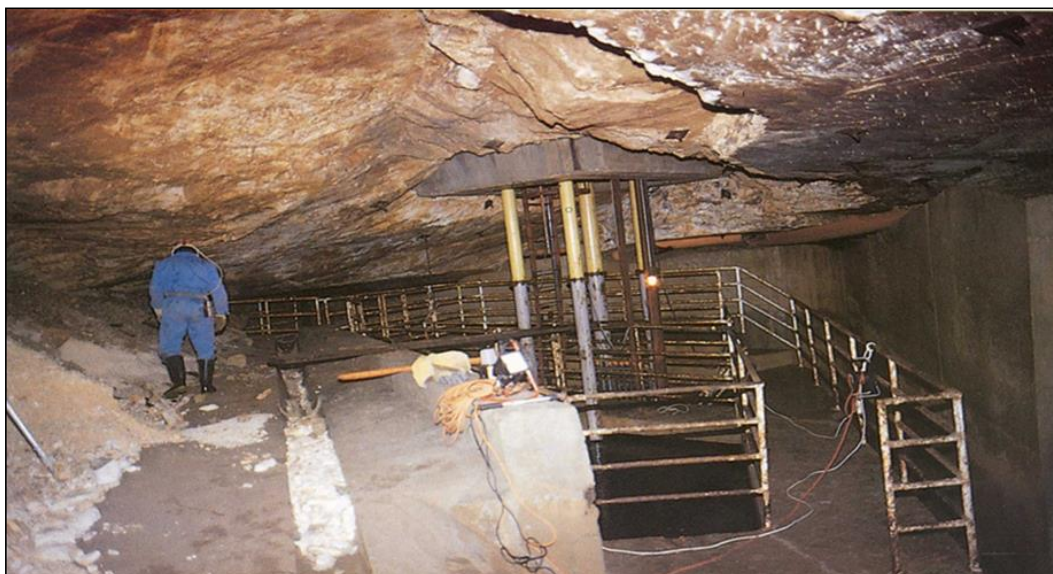
Sl. 20. Vodozahvat Tunel Učka
