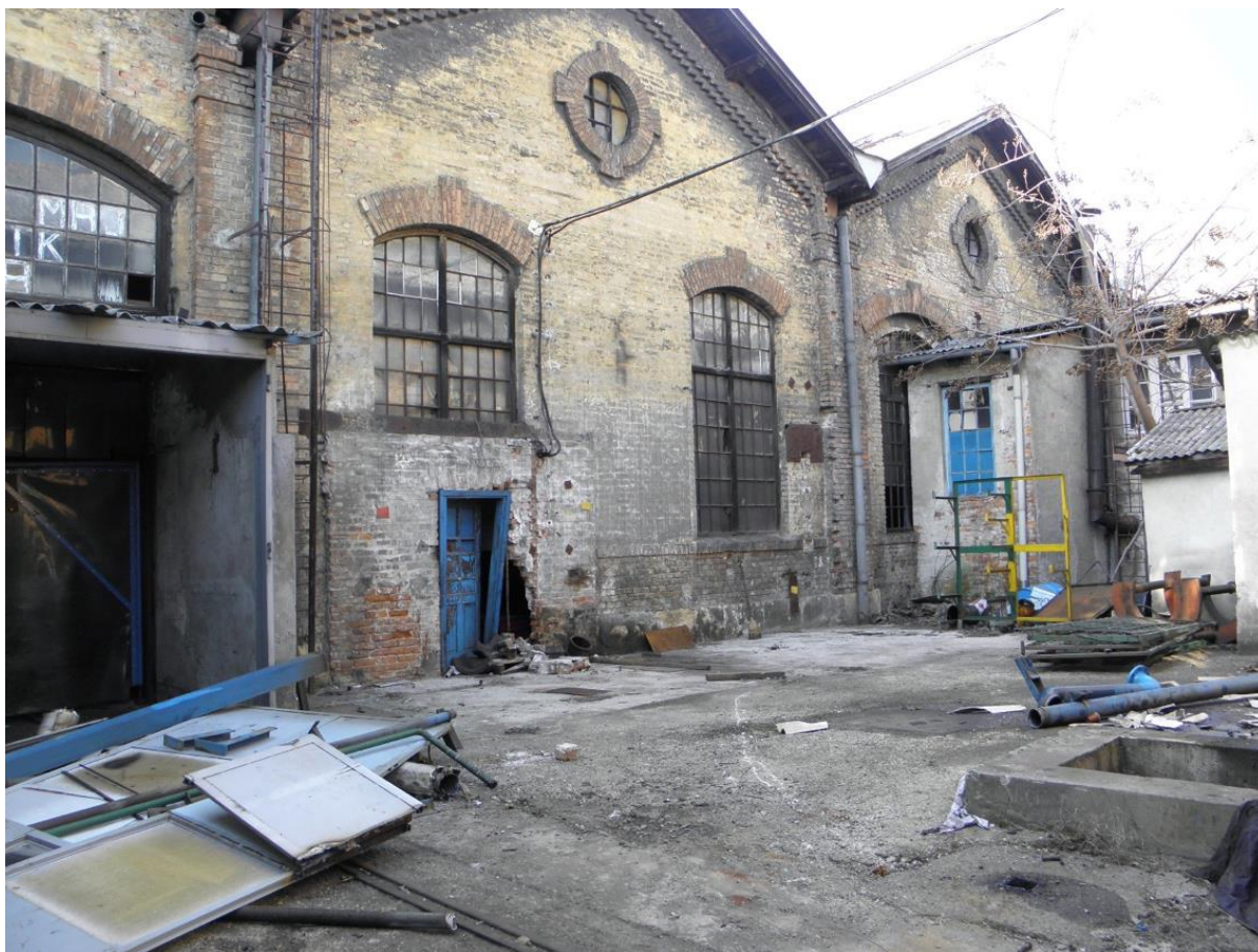
Sl.14. Uništeni sklop Tvornice željezničkih vozila „Gredelj“
