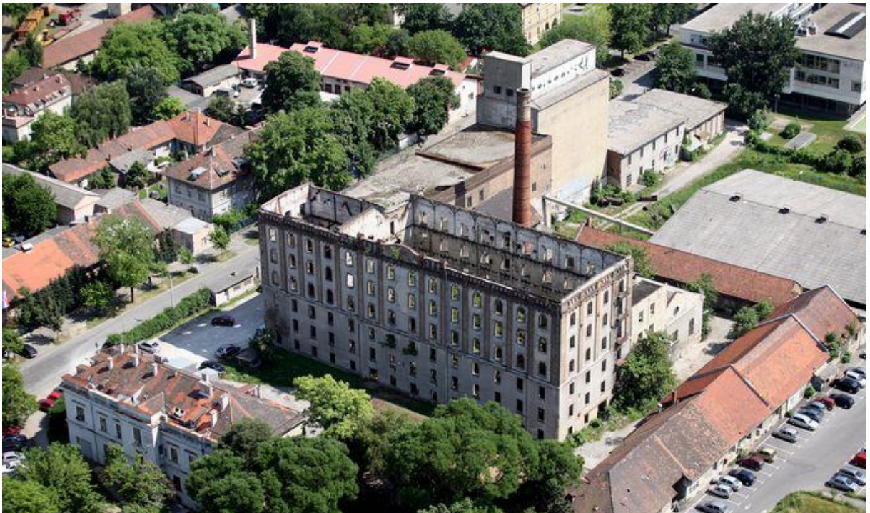
Sl.12. Pogled iz zraka na urušeni krov Paromlina
