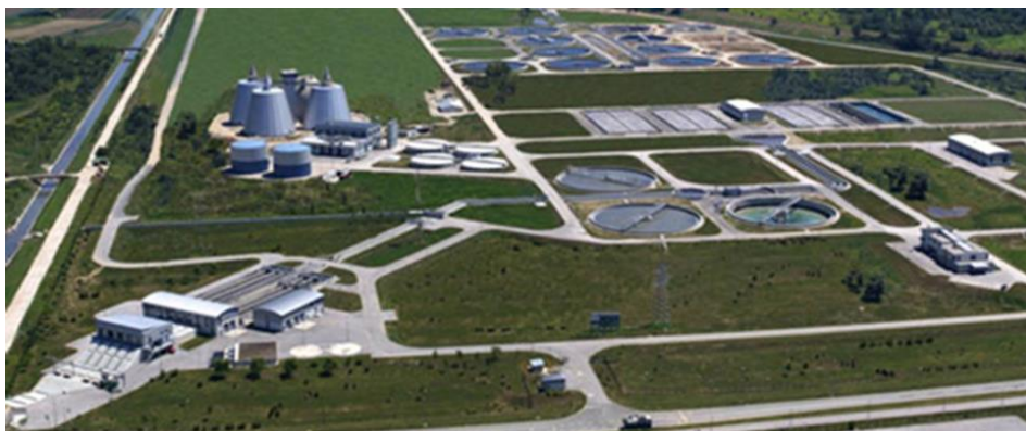
Slika 4. Centralni uređaj za pročišćavanje otpadnih voda grada Zagreba (preuzeto iz URL 5).
