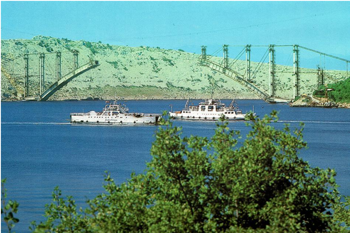
Sl. 7. Gradnja Krčkog mosta
