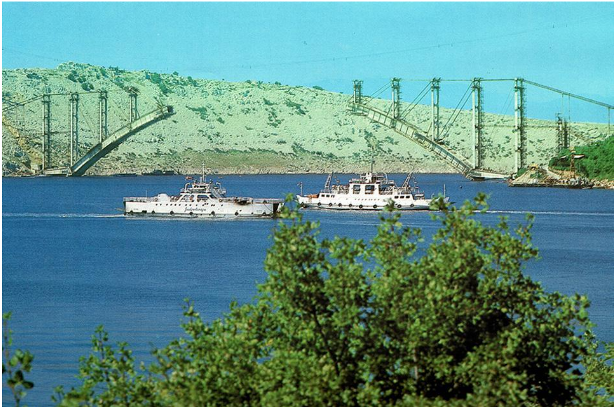
Sl. 7. Gradnja Krčkog mosta
