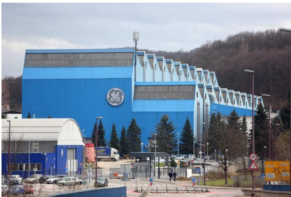
Sl. 14. General Electric danas na lokaciji bivše tvornice „Jugoturbina“
