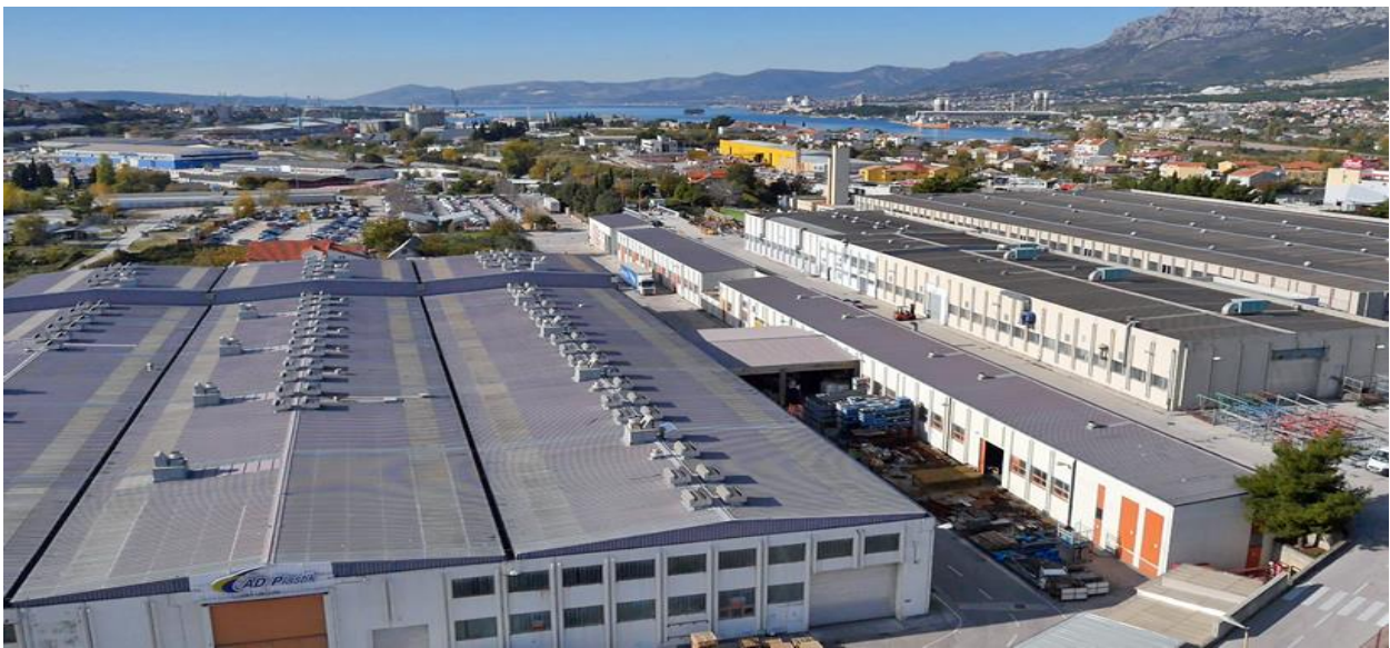
Slika 10: Sjedište i postrojenje AD Plastik d.d.
