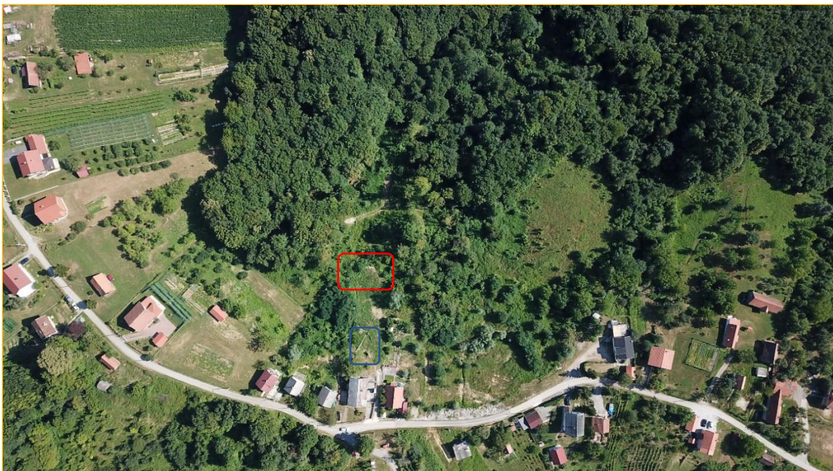
Slika 45. Aerofotografija snimljena dronom DJI Mavic Pro 1 2020. godine s označenim položajem (uklonjenog) srušenog objekta i mjesta mijenjanja položaja odvodne cijevi .
