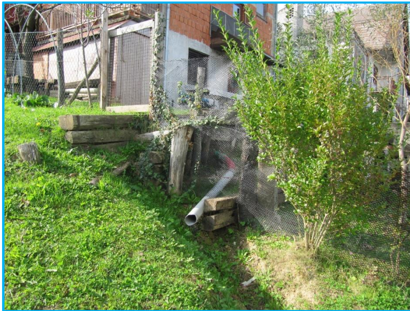
K2-photo- 149/405- odvodnja direktno u čelo klizišta.
