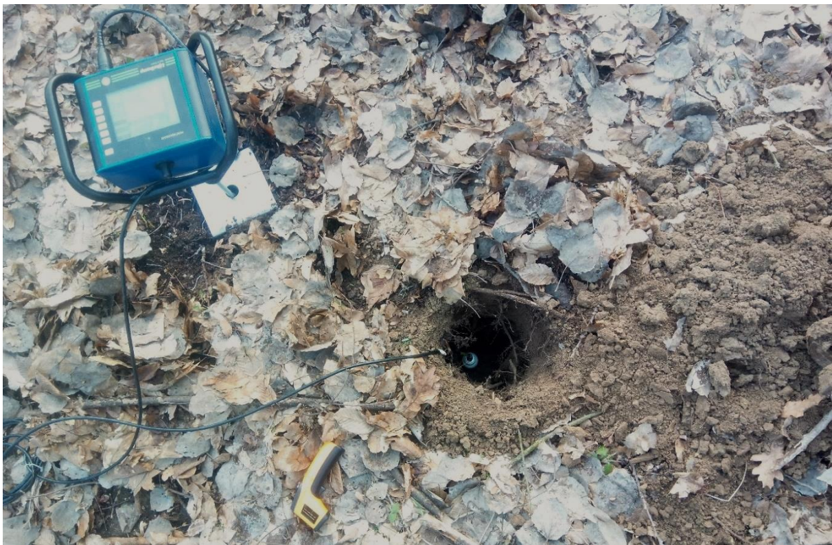
Sl. 42. In situ mjerenje digitalnim konusnim penetrometrom
