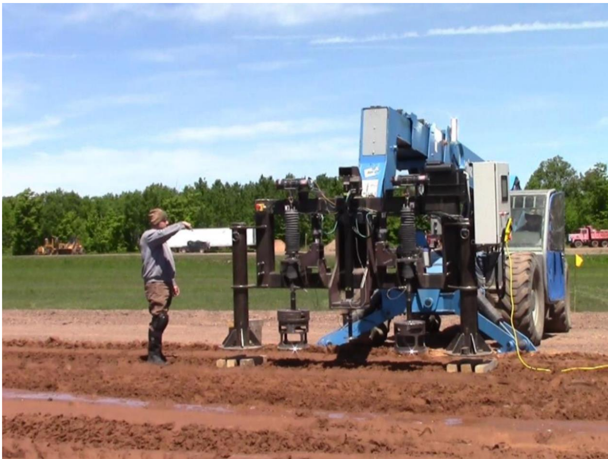
Sl. 17. Terensko mjerenje bevametrom montiranim na buldožer
