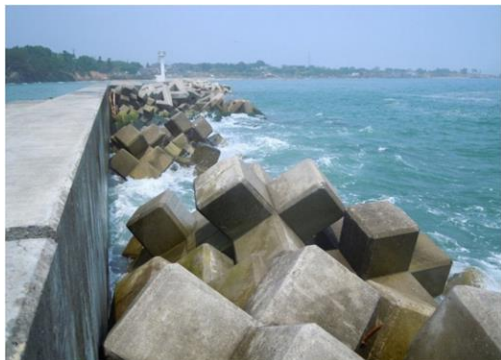
Sl.12. Sustav za zaštitu od tsunamija Izvor: Esteban i dr. (2014)
