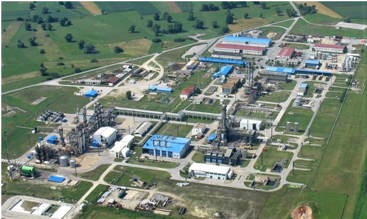
Sl. 2. Centralna plinska stanica Molve
