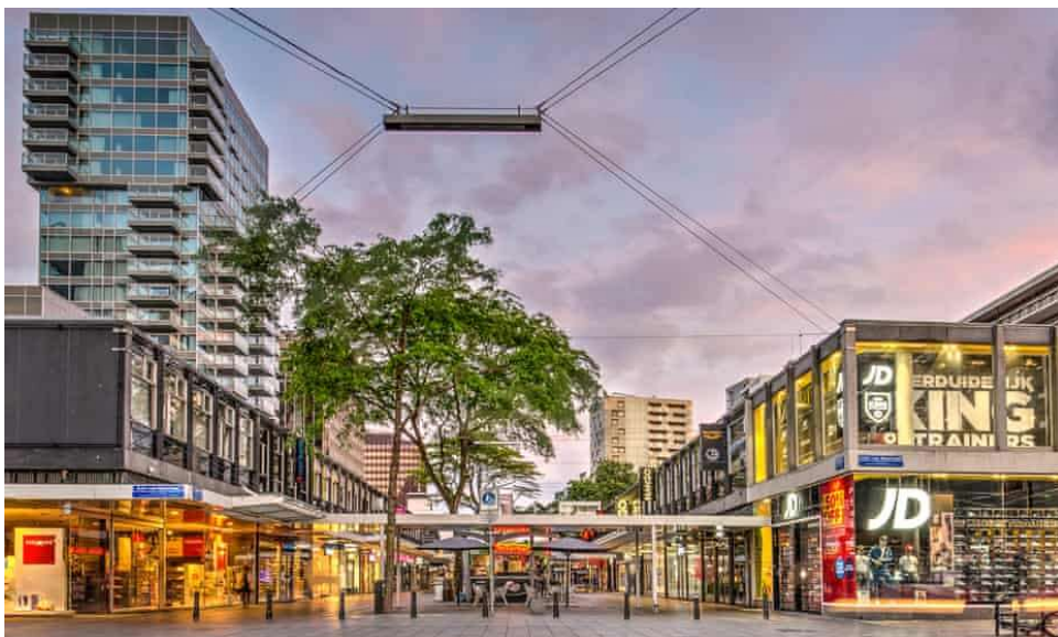
Sl. 5. Pješačko-trgovačka ulica Lijnbaan u Rotterdamu, izgrađena 1953. godine (dolje), na mjestu porušenog dijela gradskog središta (gore) Izvor: Van der Zee, 2018.
