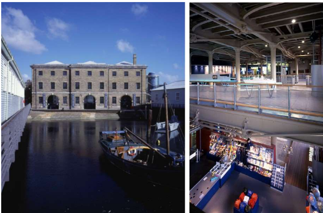
Sl. 14. Boathouse 6 u sklopu mornaričke luke u Portsmouthu: prenamjena u Institut za pomorstvo i naslijeđe
