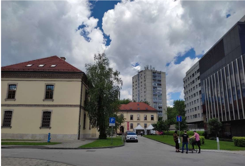
Sl. 48. Provedene prenamjene postojećih zgrada i nova gradnja u kompleksu vojarne na Črnomercu Izvor: autorica, 2021.
