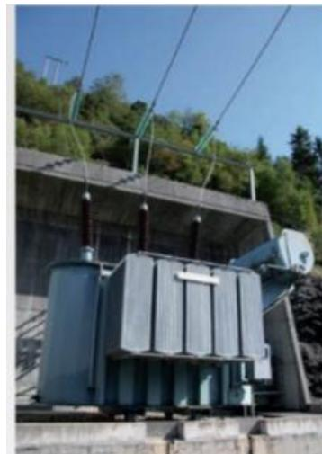
Slika 8.4 Visokonaponski transformator
