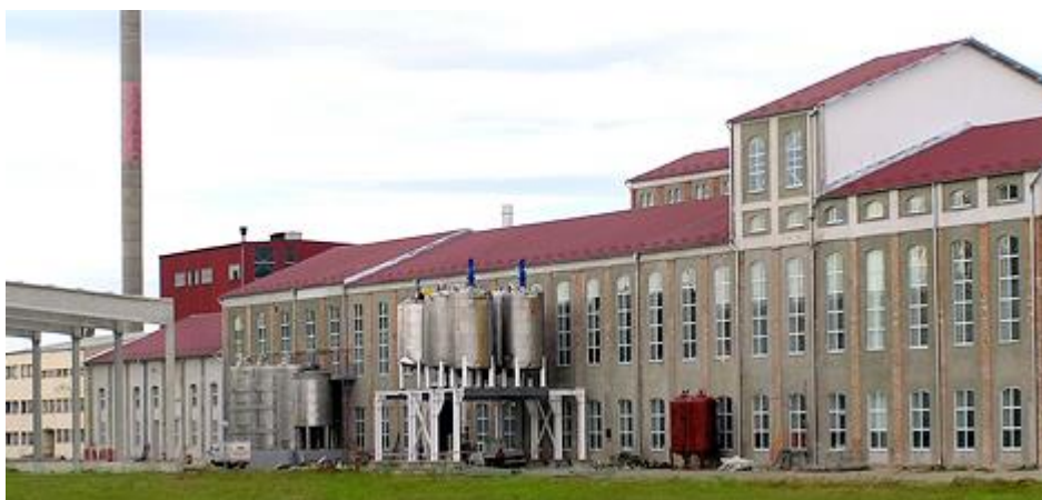
Sl. 28. Obnovljena škrobara u Šećerani
