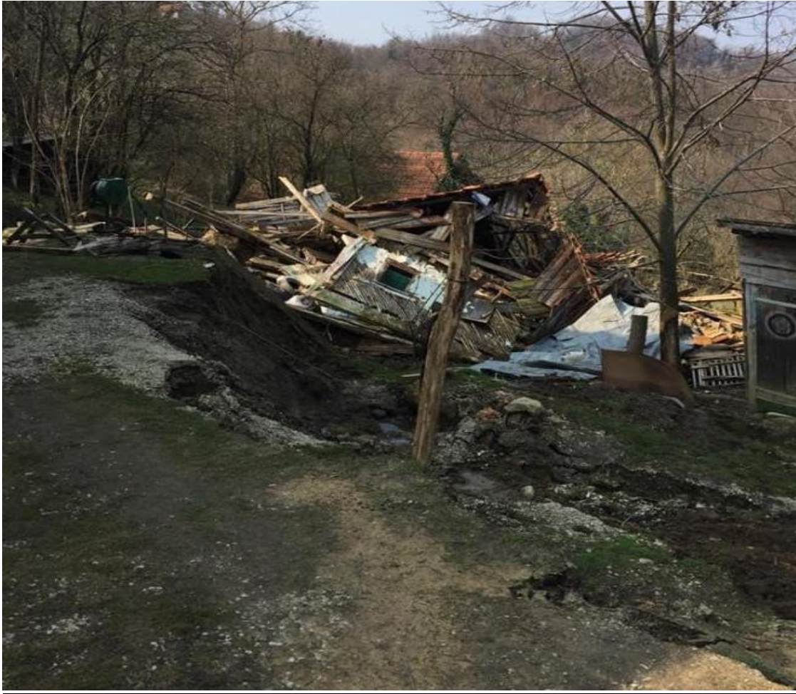
Sl. 25. Klizište uzrokovalo rušenje stare kuće na Vinagori
