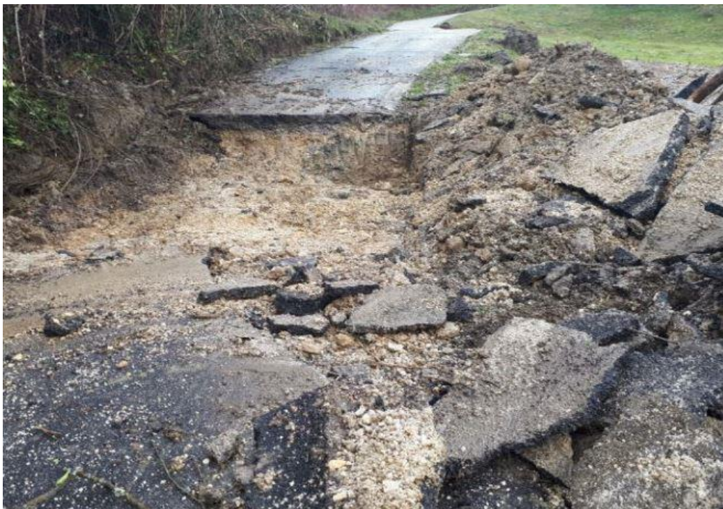
Sl. 21. Klizište na nerazvrstanoj cesti prema zaselku Johčeti u Hromcu, Općina Đurmanec
