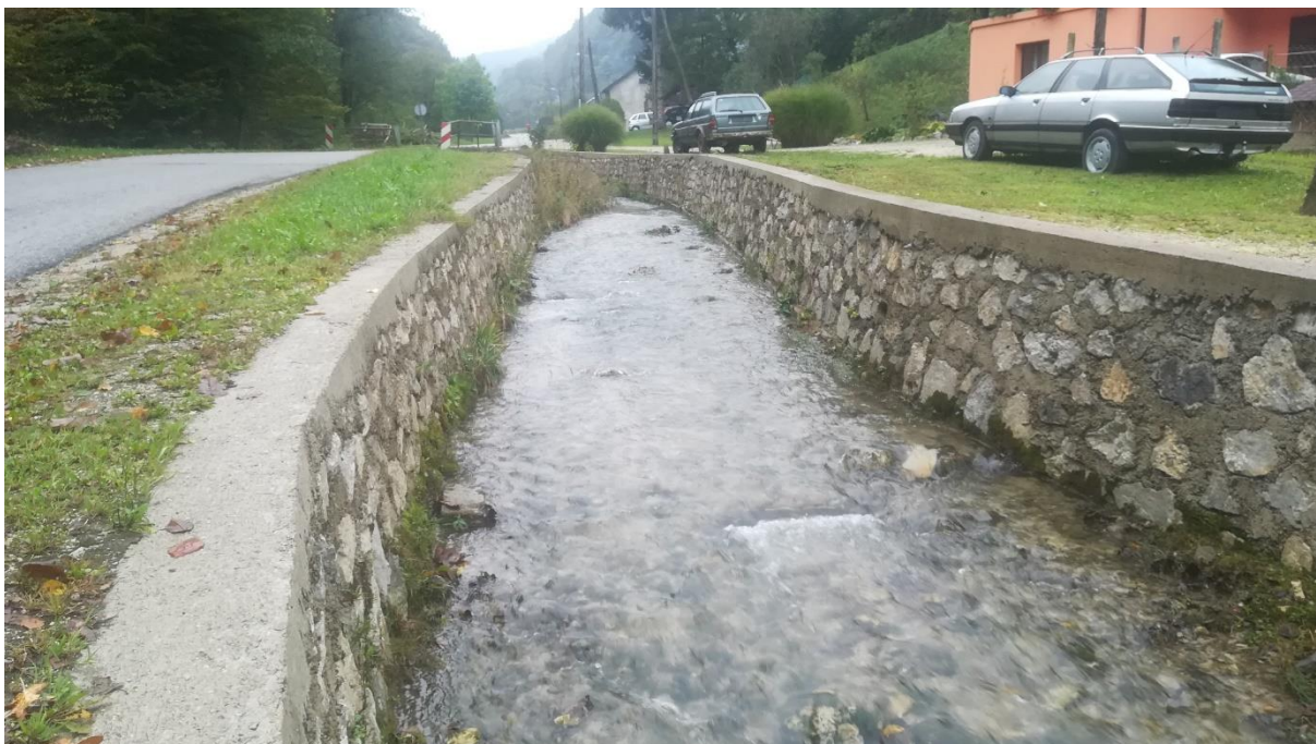
Sl. 29. Kamenom obzidane obale i izravnano dno na Breganici u naselju Breganica (snimila V. Curman, 09.10.2021.)
