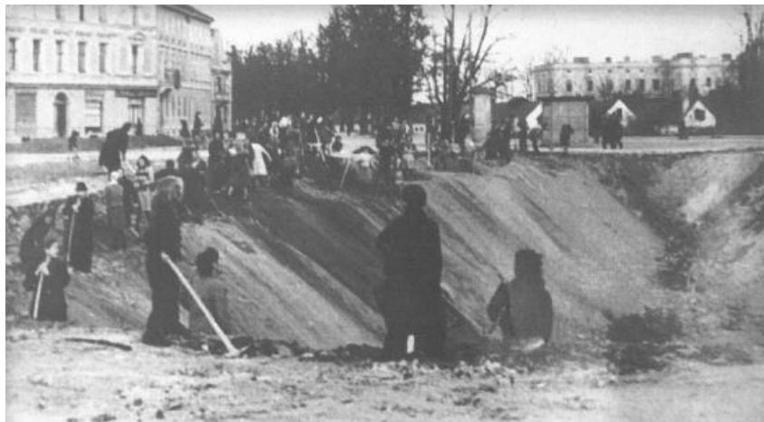
Sl. 7. Zatrpavanje šanca u Karlovcu
