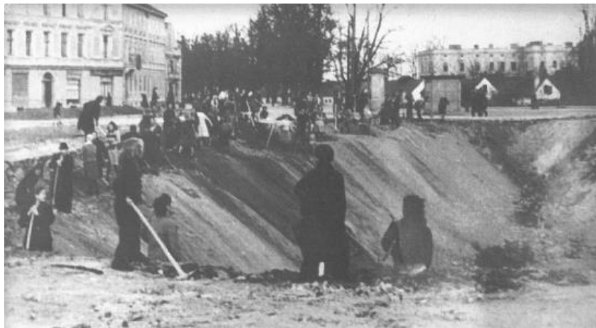
Sl. 7. Zatrpavanje šanca u Karlovcu
