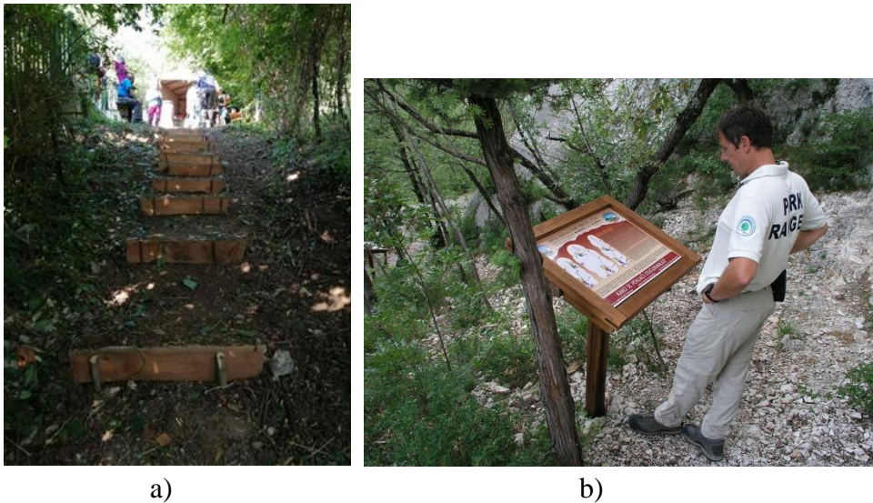
Sl. 35. a) Primjer stepenica konstruiranih pomoću drvenih gredica (URL5); b) Primjer kose interpretacijske ploče izrađene od drvenog materijala (URL6)
