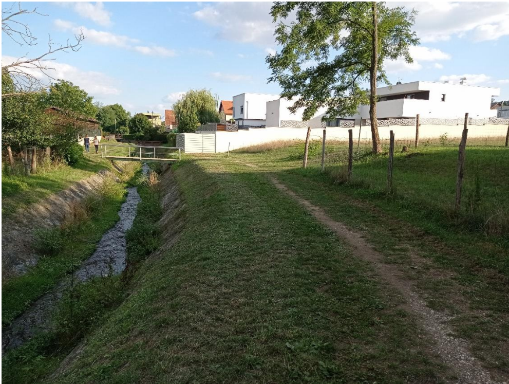
Sl. 20. Dio koridora Blizneca između retencije u Jazbini i Maksimira, 2. rujna 2021.
