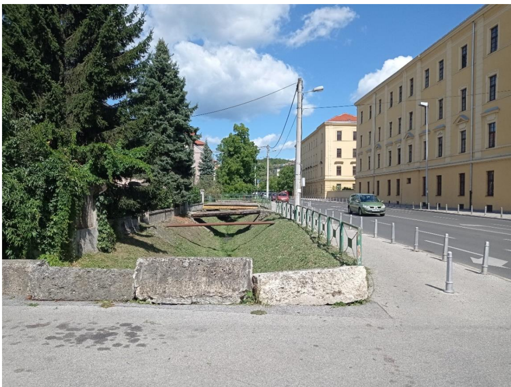
Sl. 19. Koridor potoka Črnomerca sjeverno od Ilice (pogled prema sjeveru), 1. rujna 2021.
