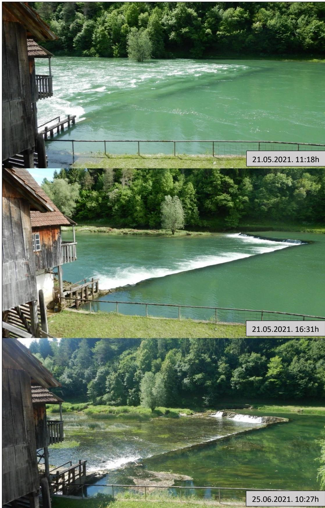
S1.33. Vodostaj Donje Dobre na lokaciji Protulipa tijekom vodnog vala iz HE Lešće (slika gore), tijekom smanjivanja vodnog vala (slika u sredini) i tijekom perioda kada hidroelektrana pušta biološki minimum (slika dole)
