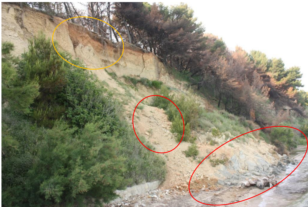
Slika 37. Područje gravitacijskog kretanja materijala na dijelu klifa Duilovo uz betoniranu plažu, svibanj 2018.
