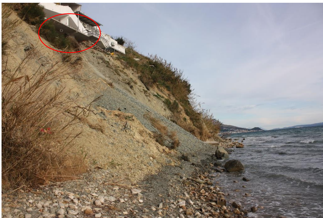
Slika 50. Dno klifa ispod kuće, veljača 2020.
