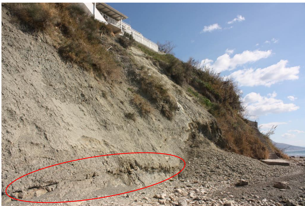
Slika 49. Dno klifa ispod kuće, ožujak 2019.
