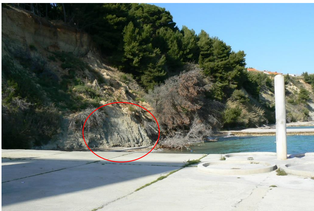
Slika 32. Dio istraživanog područja na klifu Duilovo uz betoniranu plažu, travanj 2012.
