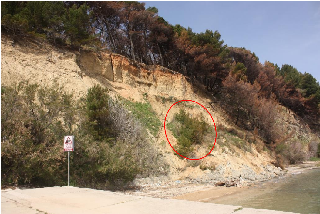
Slika 36. Područje gravitacijskog kretanja materijala na dijelu klifa Duilovo uz betoniranu plažu, travanj 2018.
