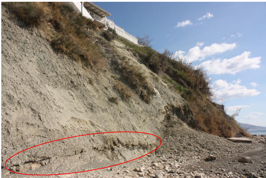
Slika 49. Dno klifa ispod kuće, ožujak 2019.
