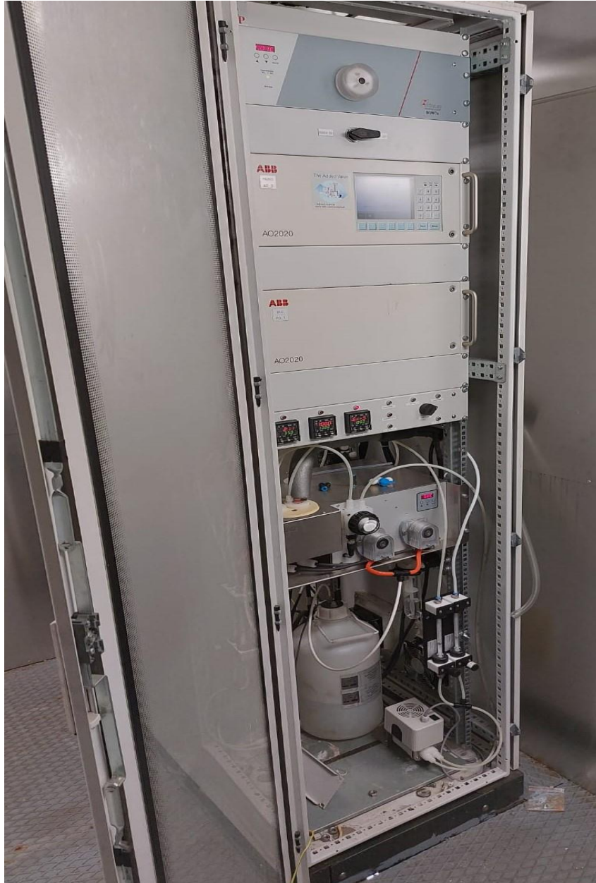
Sl. 7. Uređaj za mjerenje emisija u zrak
